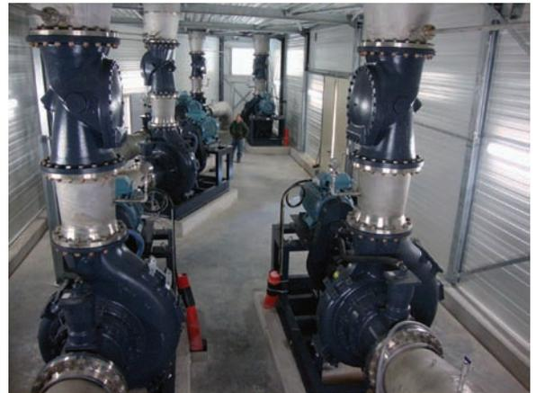
EXPANSION OF BRUSSELS SEWAGE PLANT WITH SIX CORNELL MODEL 18NHFL-RP-F20 PUMPS, EACH PUMPING 2500M3 PER HOUR
